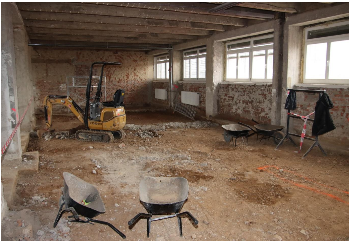
Pohled na bývalé prostory Radia Proglas v prvním podpodlaží.
