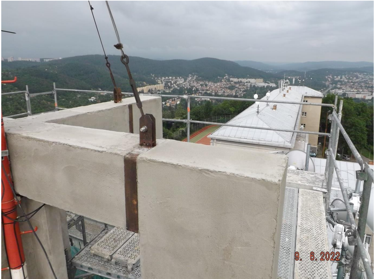
Byla zpevněna a nově oplechována také nosná konstrukce vysílacích antén.
